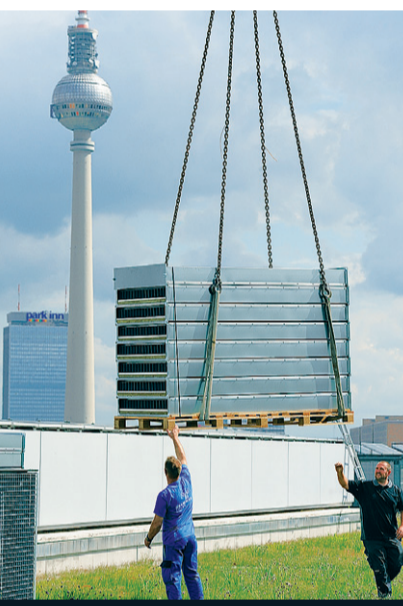
ENERGETISCHE MODERNISIERUNG: Contracting bietet individuelle Konzepte zur Planung und Finanzierung. FOTO: DENA
