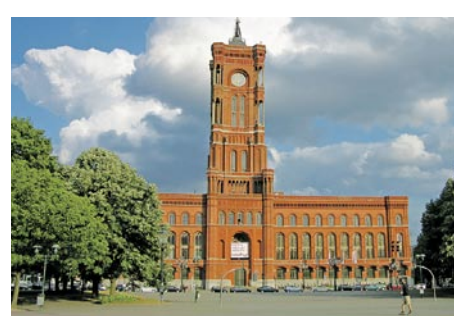
Zu den 40 Liegenschaften, die das Modellprojekt „Energiesparpartnerschaft Berlin“ umfasst, gehört auch das Rote Rathaus. Hier wurde durch die Evonik New Energies GmbH ein Einspar-Contracting realisiert.
